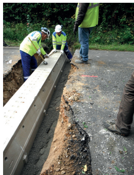
Au total, 17 traversées de 8 mètres chacune vont être installées sur les routes du marais de Cré sur Loir/La Flèche, de manière à amener les batraciens à emprunter les couloirs de migration, sous la chaussée.
