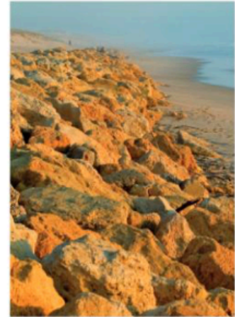
B Un perré en blocs de calcaire.
